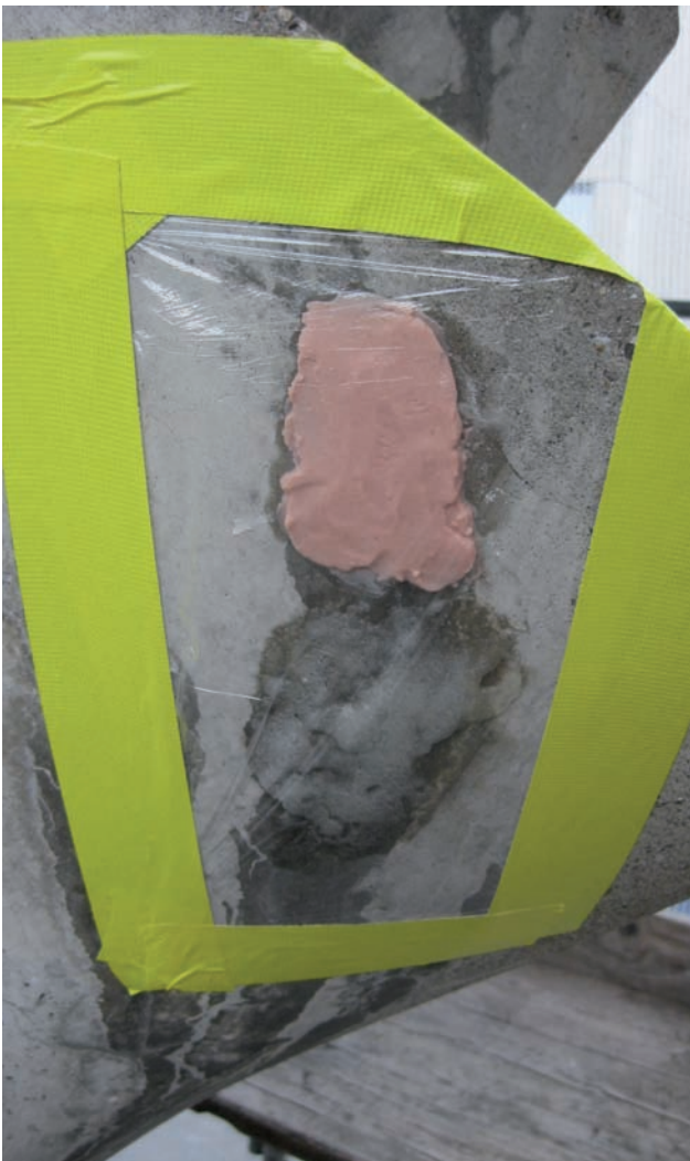
Abb. 8: Reduktion der Krusten und Verfärbungen, u. a. mit reaktiven Kompressen.
