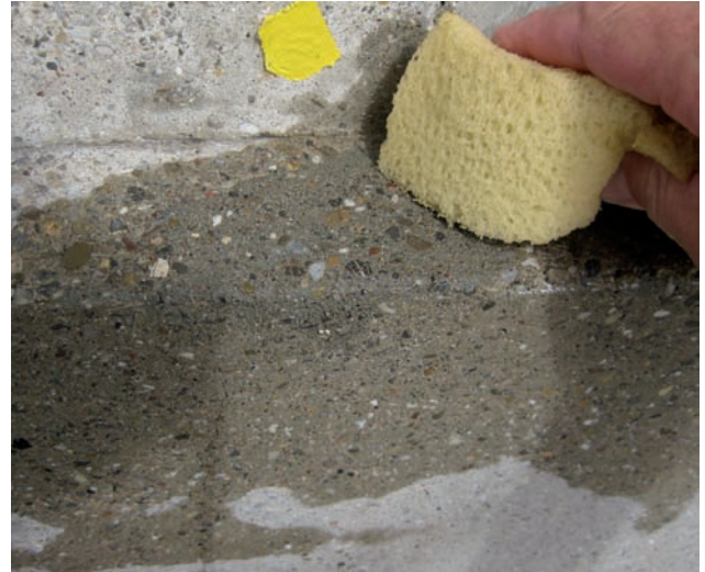
Abb. 9: Fehlstelle aus Abb. 7. Der Betonersatzmörtel wurde in Korn und Oberflächenstruktur jeweils der unmittelbaren Umgebung angepasst.
