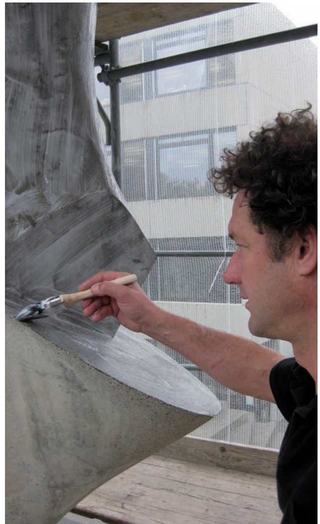
Abb. 10: Finale Imprägnierung mit einer Hydrophobierungscreme.
